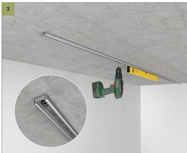
Fissare il Binario di Supporto a soffitto e metterlo in bolla. Se necessario utilizzare delle guarnizioni flessibili, per esempio gomma o schiuma tra soffitto e Binario. Si raccomanda di utilizzare fissaggi idonei alla tipologia di soffitto. Se necessario, utilizzare il Fine corsa in corrispondenza della fine del Binario di Supporto.
