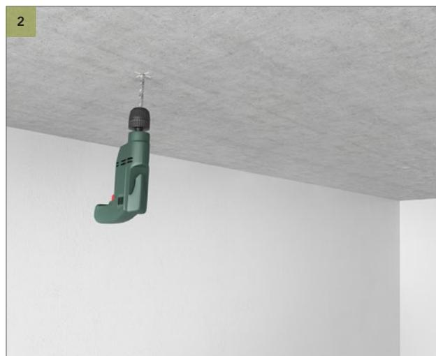
Realizzare i fori a soffitto per predisporre il Binario di Supporto. Usare fissaggi appropriati al tipo di soffitto.
