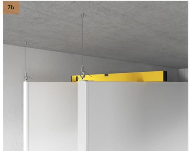
Posizionare la livella sopra o sotto i baffles per assicurare l'uniformità in altezza dell'installazione. Il livellamento può essere fatto rilasciando il modulo sul gancio e poi regolando la lunghezza del cavo metallico.
