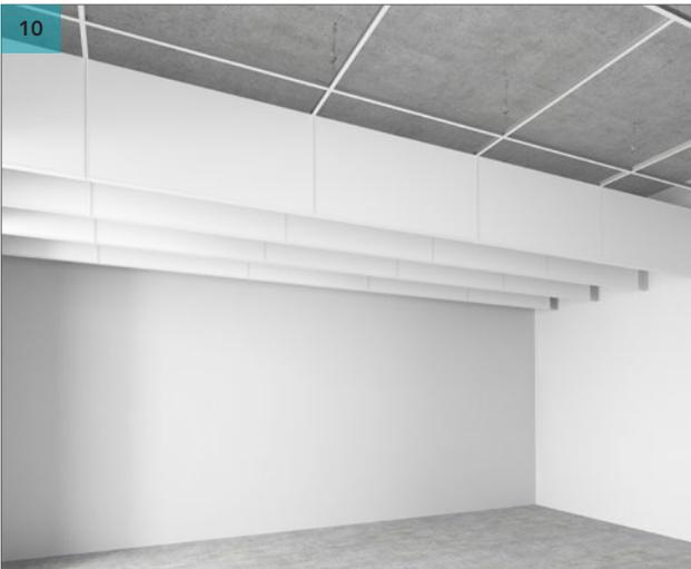
Fissare i Rockfon Universal Baffles alla struttura T24 e allinearli usando come riferimento i piccoli incavi realizzati nella parte inferiore della cornice laterale di ogni Baffles.
