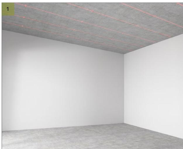
Usare un laser per demarcare i punti di fissaggio in linee diritte. Marca i tuoi punti di fissaggio a soffitto in corrispondenza dei due estremi del Binario di Supporto e del suo centro.
