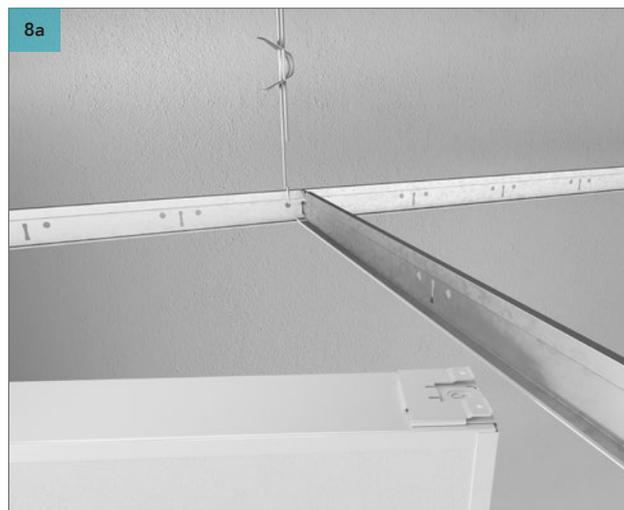
Fissare Rockfon Universal Baffle mediante la clip multifunzione, integrata nella cornice metallica, alla struttura Chicago Metallic T24.
