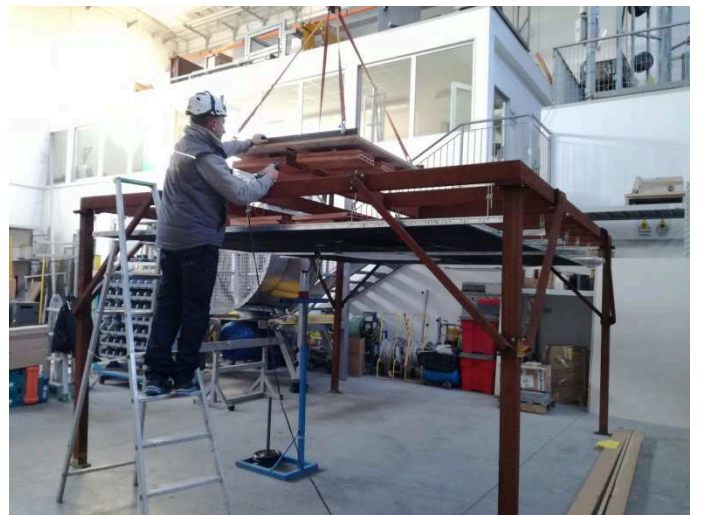
Fotografia della porzione di controsoffitto "A" dopo l'impatto n. 5
