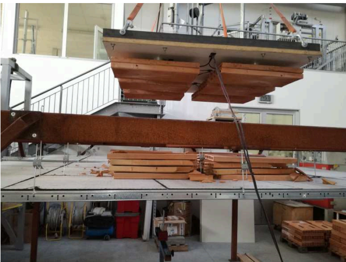
Fotografia della porzione di controsoffitto "A" prima dell'impatto n. 5
